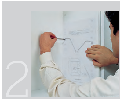
2 Markierung der Bohrpunkte mit einem Stichel über der Anschlagzeichnung. Es existieren verschiedene Möglichkeiten hinsichtlich des gewünschten Montagewinkels des Abtropfbords. Die Schritte 1 und 2 werden an beiden Möbelseiten durchgeführt.
